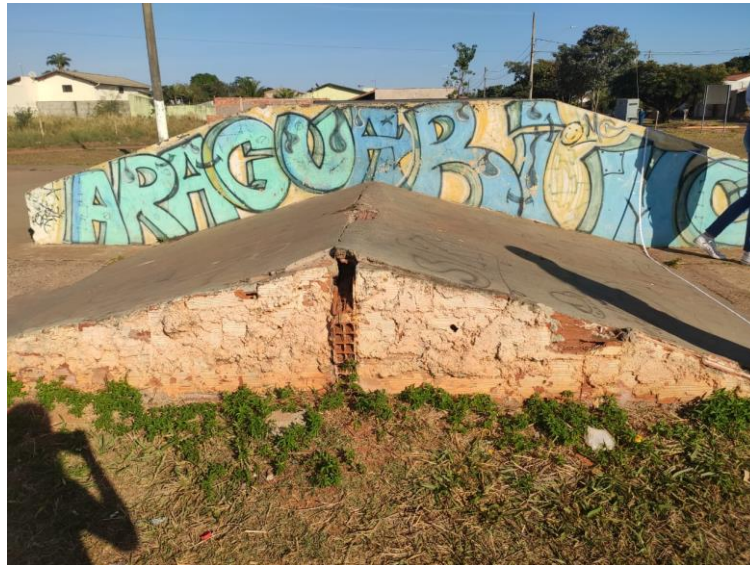
Imagem 1. Foto da pista a ser demolida e refeita
