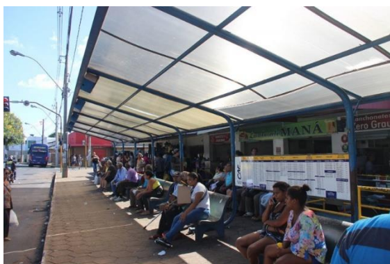
Figura 1 - Abrigo existente a ser removido.
