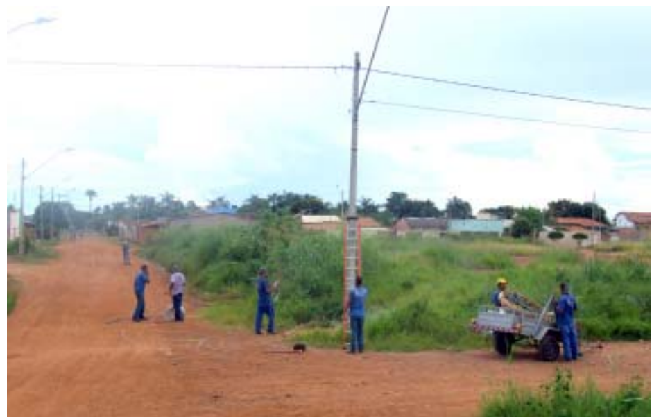
Além da substituição das lâmpadas a vapor de sódio, a Prefeitura de Araguari também está levando iluminação para os locais que ainda não dispunha do benefício - como o Bairro Palmeiras de Império.
