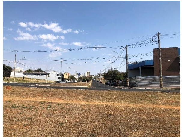
Foto 4. Trecho canalizado do córrego. Vista de montante a partir da Av. Minas Gerais.
