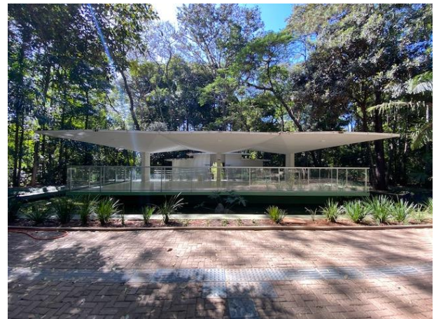
Foto 4. Palco com lago a frente e sanitários ao fundo.
