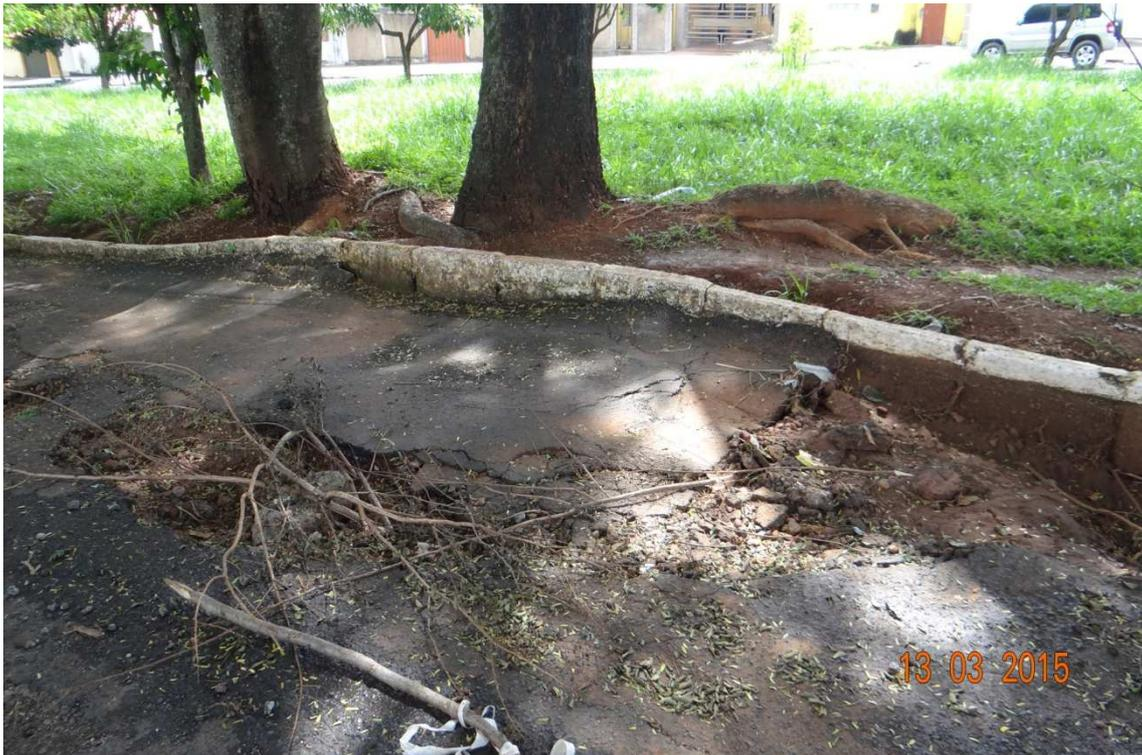
Figura02: Vista geral da danificação do asfalto feita pelas raízes das árvores.
