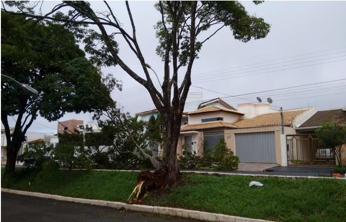
Figura 01: Vista geral do indivíduo arbóreo que caiu, e ao outra em pé está com estado fitossanitário comprometido.
