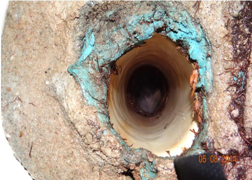
Figura 05: Imagem do esgoto cheio de raízes.
