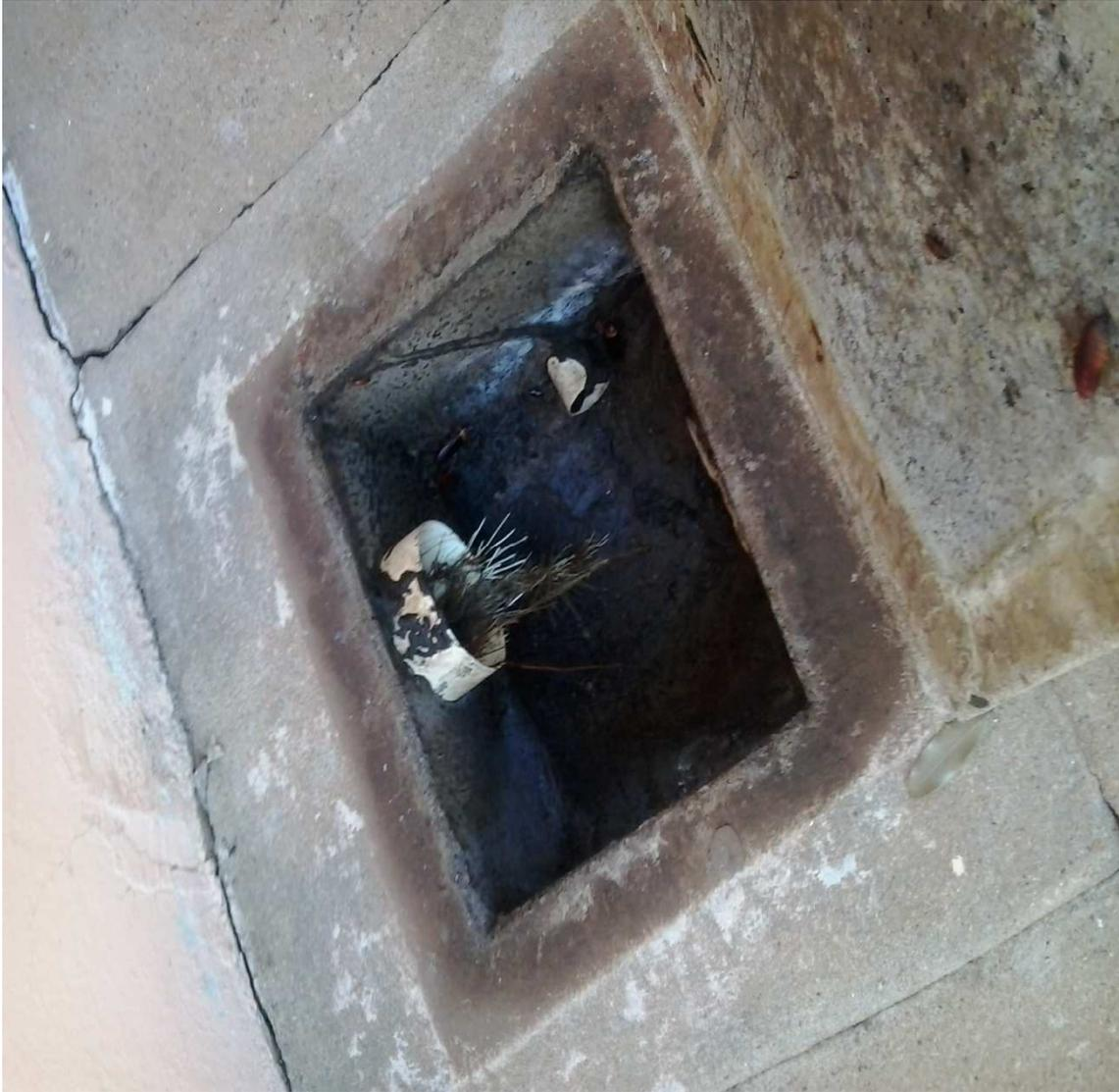
Figura 02: Raízes do indivíduo arbóreo invadindo a rede de esgoto da residência do Sr. Hélio Gonçalves na av. Minas Gerais, 3535.
