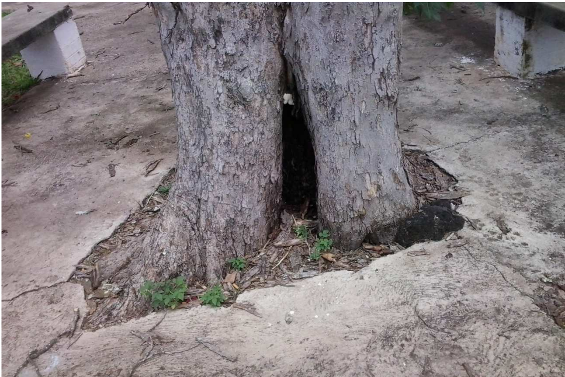
Figura 02: Vista da rachadura na base do tronco da Sibipiruna.
