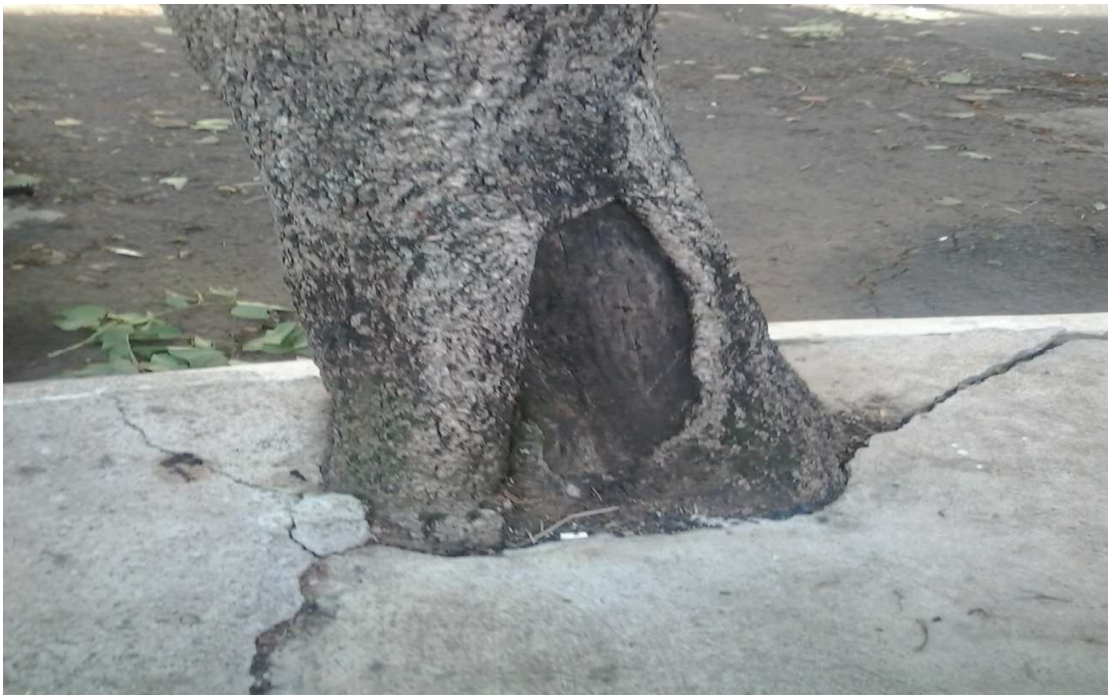
Figura 02: A base está toda danificada com cimento em volta.
