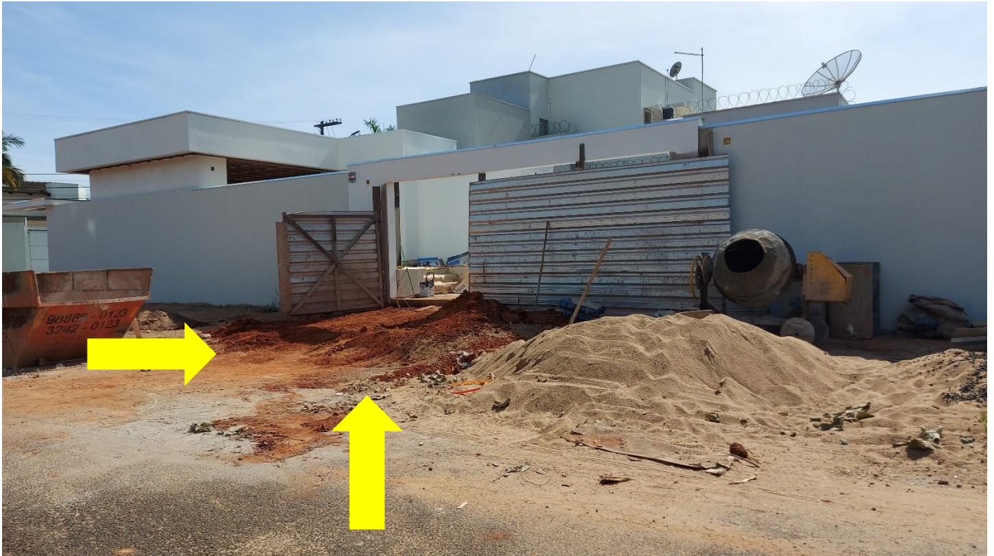
Foto 01: Local exato onde encontrava-se o Pequizeiro; a denunciada não procurou a Secretaria de Meio Ambiente para solicitar a supressão da árvore
