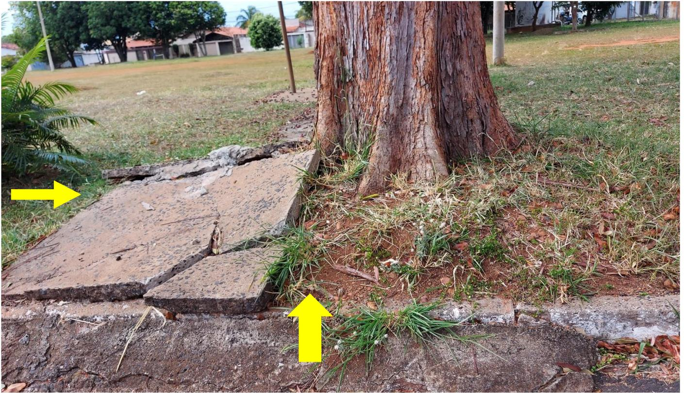
**Foto 02: Raízes do Eucalipto já causaram dano à estrutura da Praça**
