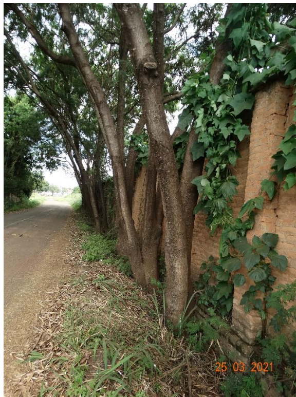
Foto 08: Várias Leucenas (espécies invasoras) vigorosas no acesso ao Palácio dos Ferroviários pela Rua Luiz Schinoor em conflito com muro
