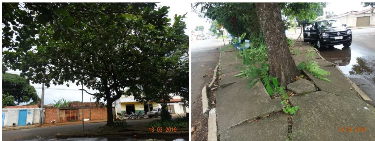
Figuras 01 e 02 – Danos causados ao calçamento do local e vista geral do indivíduo arbóreo.
