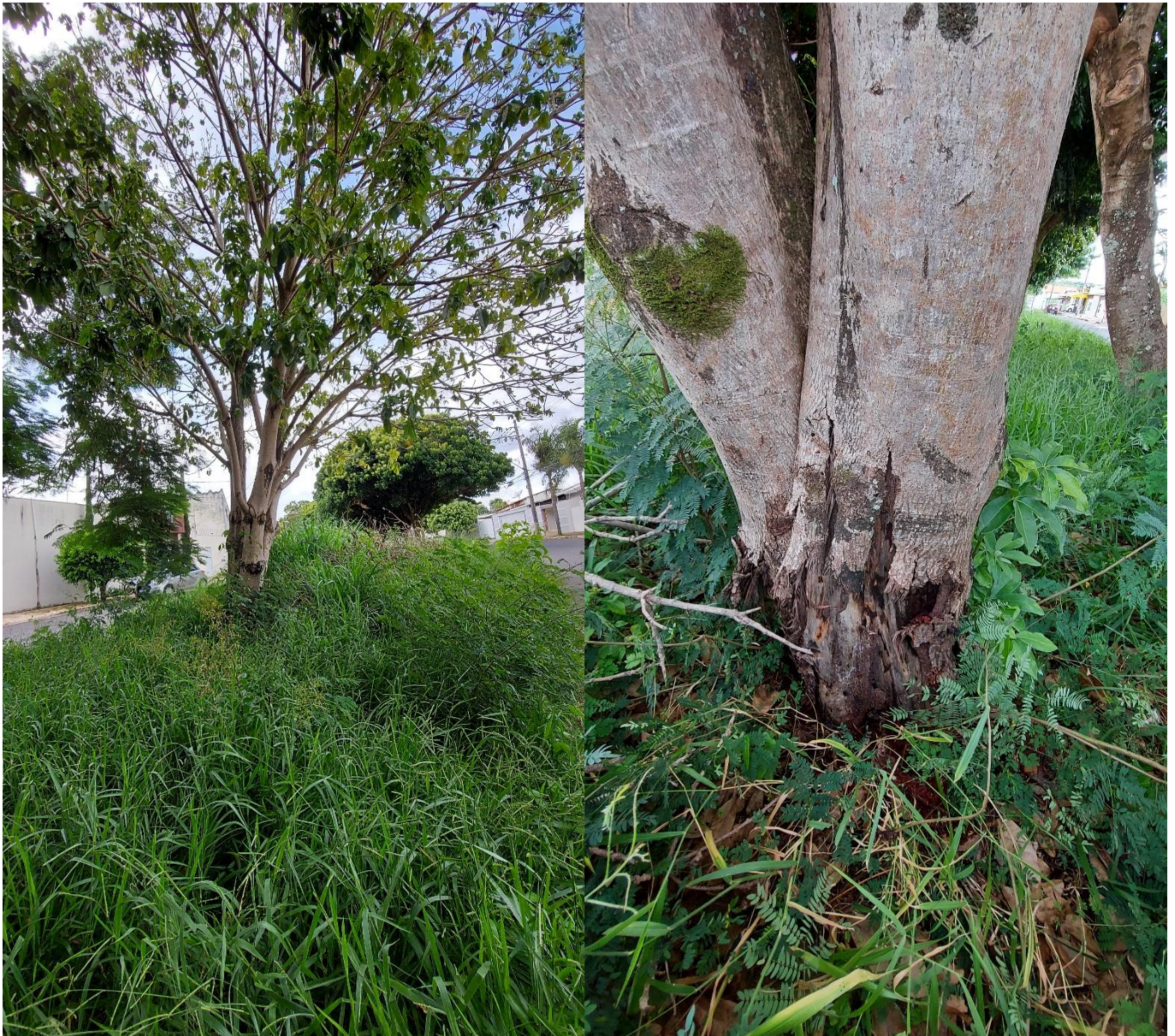
Fotos 03 e 04: Munguba com a base do tronco comprometida; árvore com risco iminente de queda
