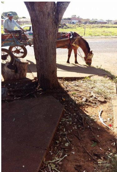
Figura 01: Vista geral do indivíduo arbóreo danificando o calçamento da praça.
