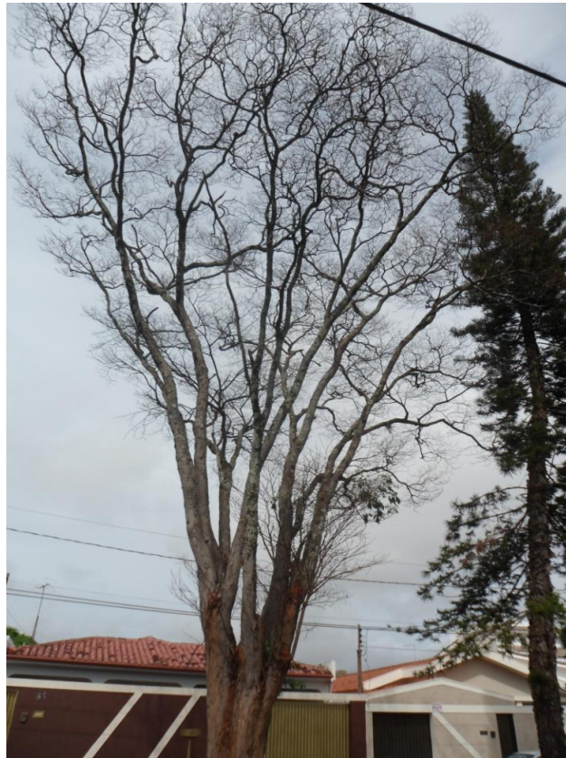
Figura 06 – Vista geral demonstrando que a árvore está morta.
