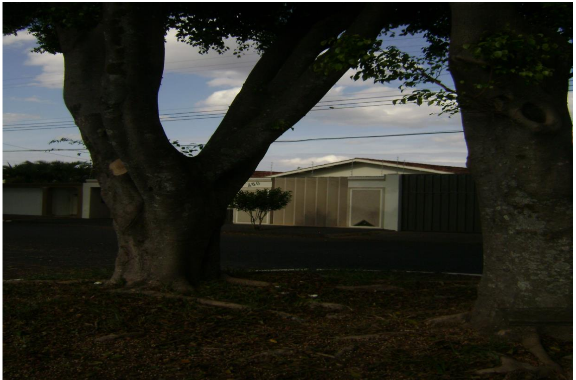
Figura 08: Árvore com ramificação inadequada o que amplia o risco de queda.
