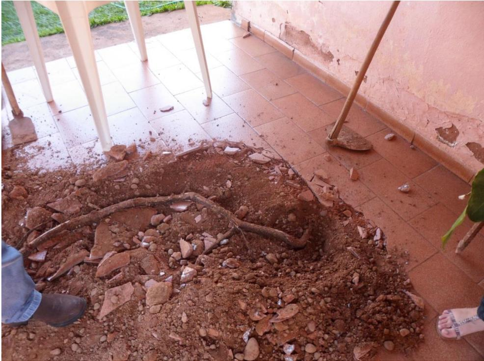
Figura 05: A raiz depois que o piso foi aberto com 15 milímetros de diâmetros.
