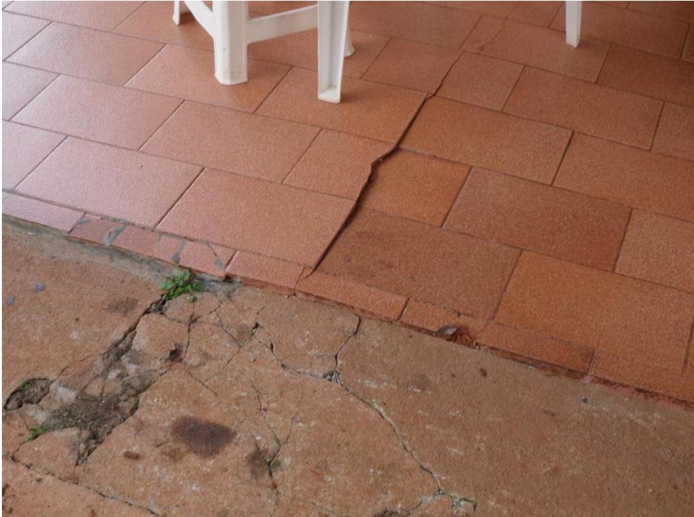
Figura 01: Raízes que provocou rachaduras e elevação no piso da residência e fissuras na parede.
